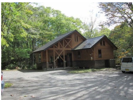
大沼園地駐車場・休息/トイレ棟
