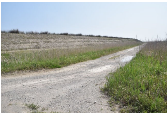
山武市井ノ内 左が人工砂丘 右が盛土
