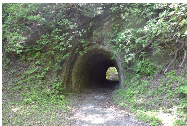
林道高宕線の素掘のトンネル
